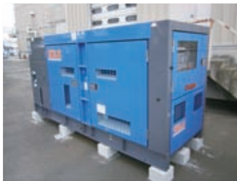
冷凍、冷蔵庫対応自家発電機
