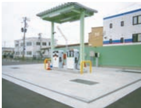
燃料備蓄兼自家用給油所
